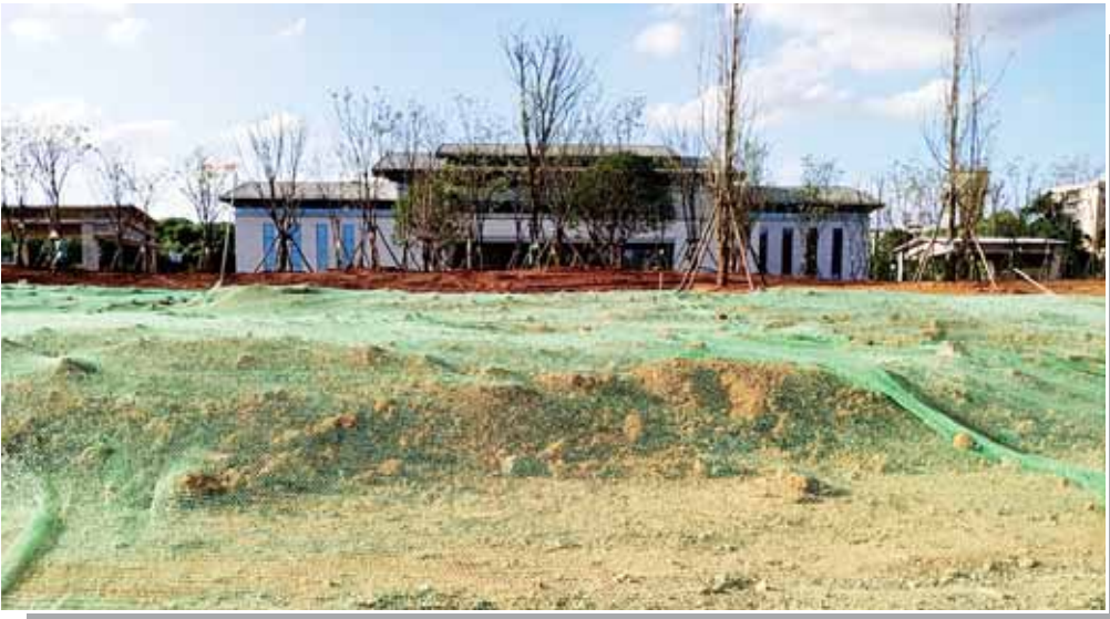
用防尘网覆盖裸土
