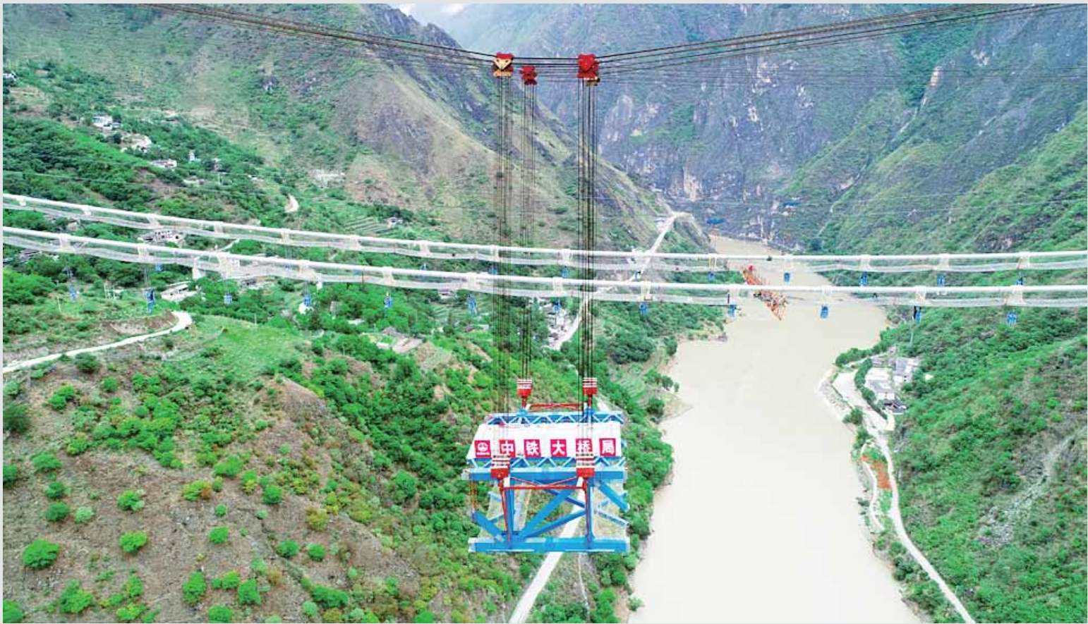
6 月 15 日,缆索吊机在吊装钢桁梁。当日,随着缆索吊机将长 24.4 米、高 12 米、重 640 吨的钢桁梁平稳固定在吊索上,由中铁大桥局承建的丽(江)香(格里拉)铁路金沙江特大桥首片中跨钢桁梁架设成功。
