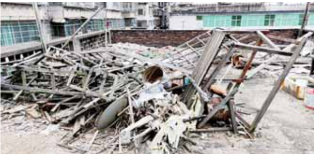
楼顶上扔弃了大量杂物垃圾
