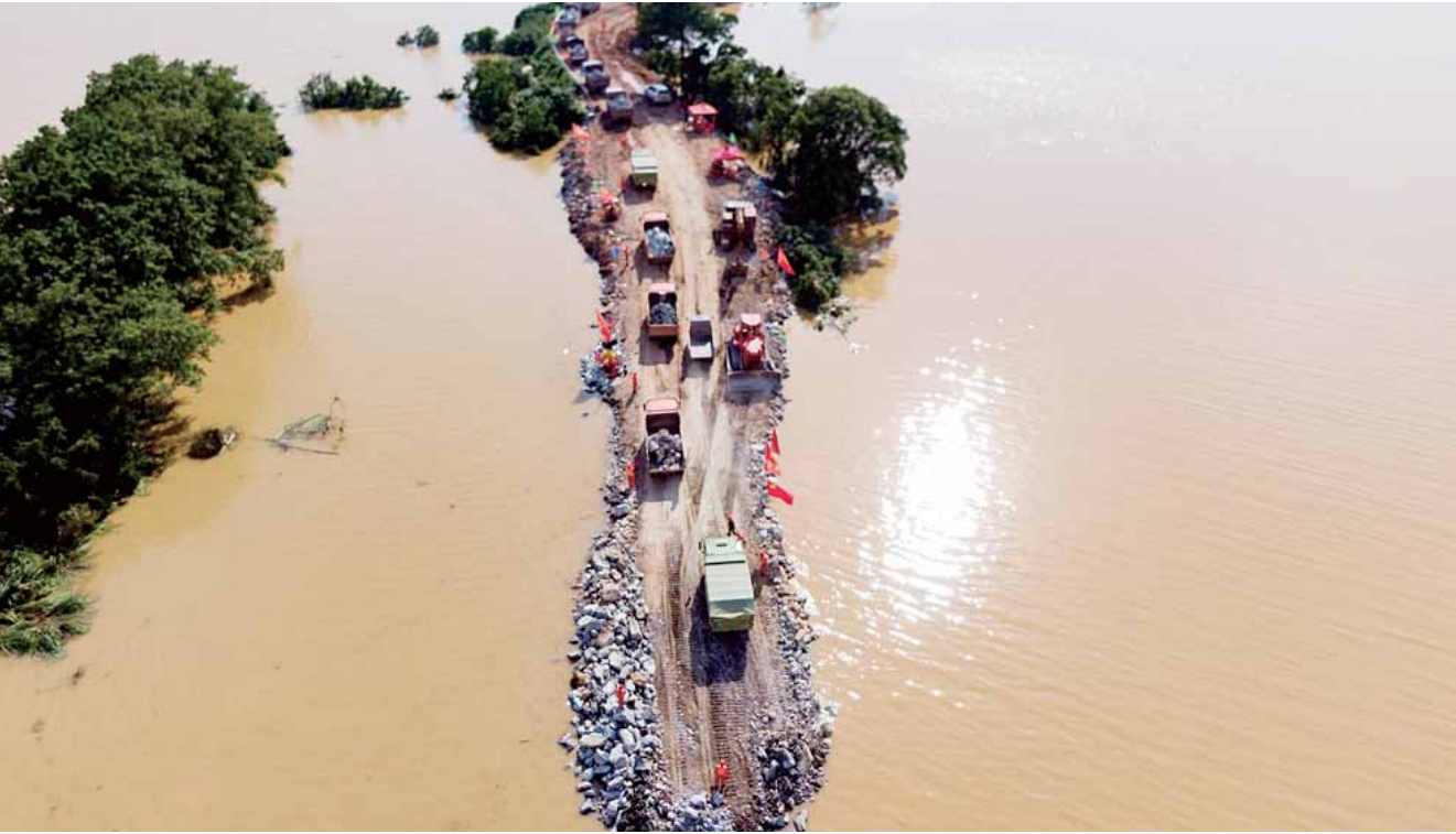
这是江西省鄱阳县鄱阳镇问桂道圩堤抢险施工现场（无人机照片，7月12日摄）。
