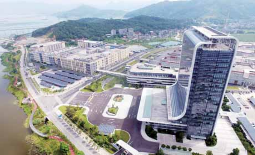
这是2019年9月11日拍摄的宁德时代新能源科技股份有限公司科技大楼和工程中心(无人机照片)。
