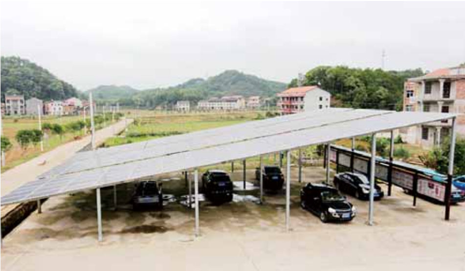
光伏发电项目
