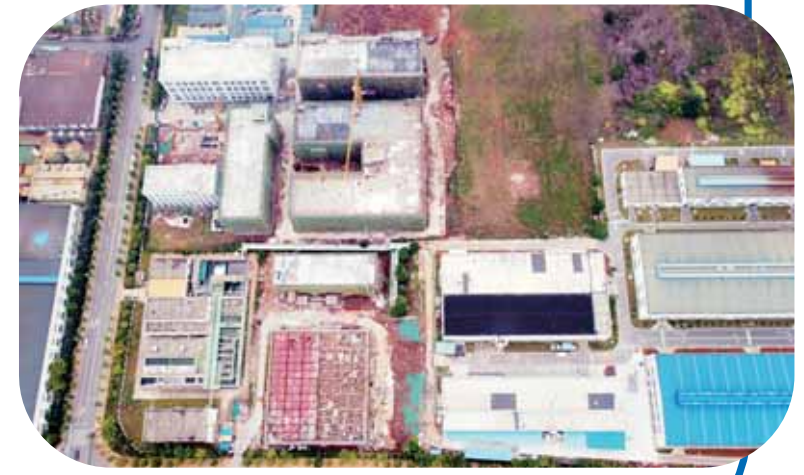
电镀厂房项目现场
