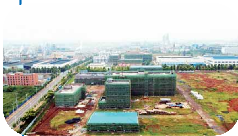
福邦新材项目现场
