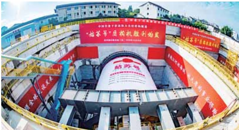
10 月 26 日,由中铁十四局集团承建的苏州市桐泾路隧道开始盾构掘进。这是目前我国首条下穿运营高速铁路的大直径盾构隧道。■新华社发
