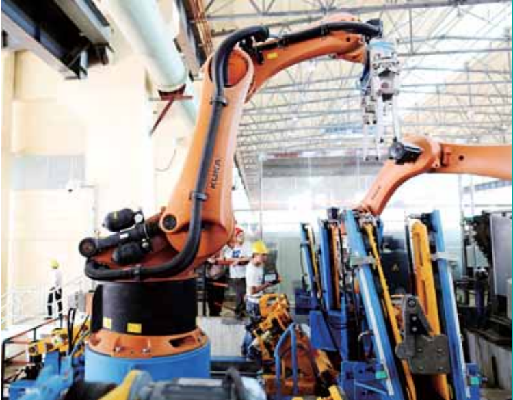
水口山金铜项目现代化厂房一角
