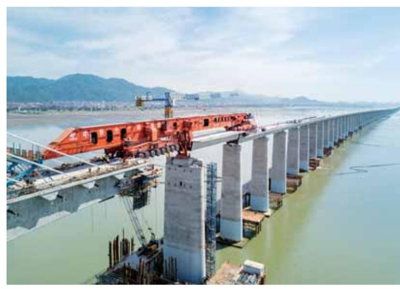
7月11日，在新建福厦铁路湄洲湾跨海大桥建设现场，中铁十一局工人协同“昆仑号”千吨级运架一体机架设该线路最后一孔40米箱梁（无人机照片）。
