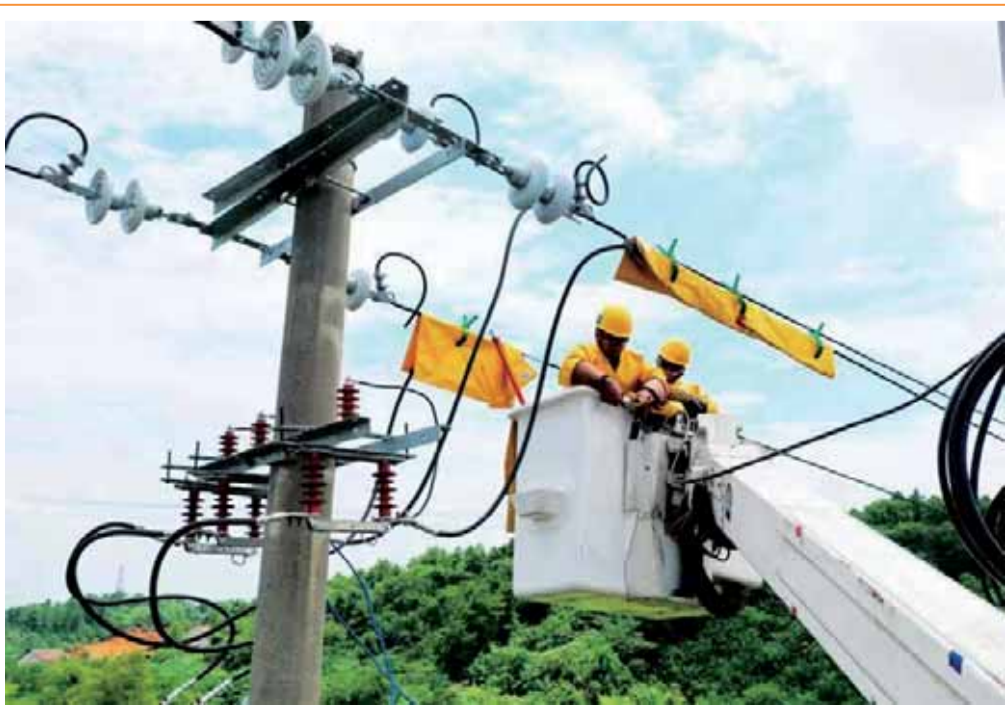
为确保客户正常用电,国网衡阳配电网检修公司带电作业班今年1至8月,累计完成不停电作业2800多次,其中抢修作业800多次,为客户多供电量1082.73万千瓦时。图为该班员工正在带电作业。 ■通讯员 汪继生 摄
