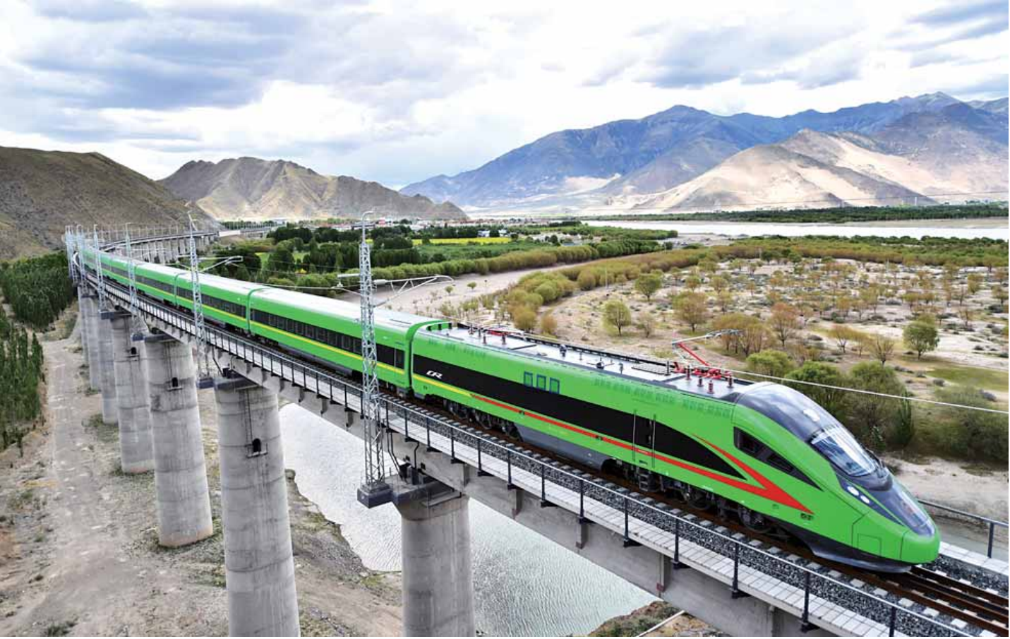
这是试运行的复兴号列车行驶在西藏山南市境内(6 月 16 日摄)。6 月 25 日,全长 435 公里、设计时速 160 公里的拉林铁路建成通车,西藏首条电气化铁路建成,同时复兴号实现对 31 个省区市全覆盖。
