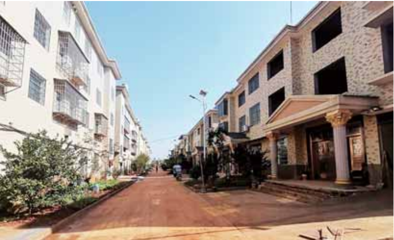
古塘村正在建设中的安置小区。
