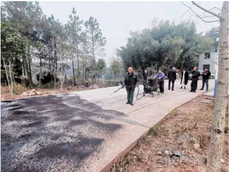
加宽的村道完工后开始铺设沥青。
