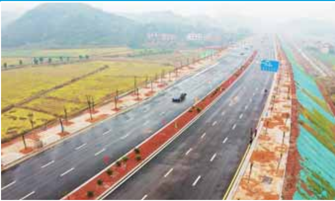
宽阔平整的创业大道竣工通车。
