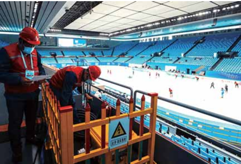
首都体育馆电力保障团队对设备进行巡视测温工作。
