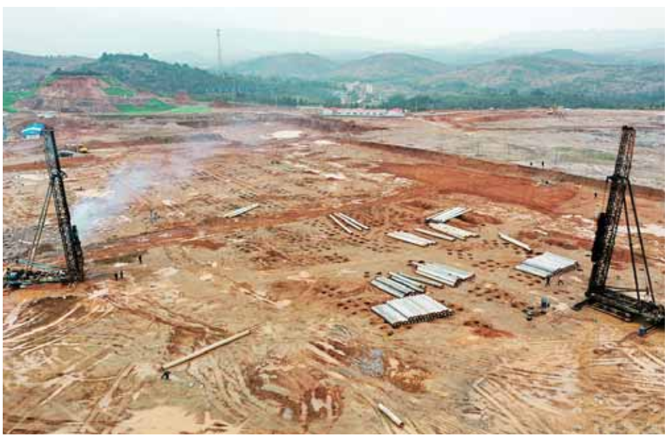
环保设施园正在进行打桩施工。
