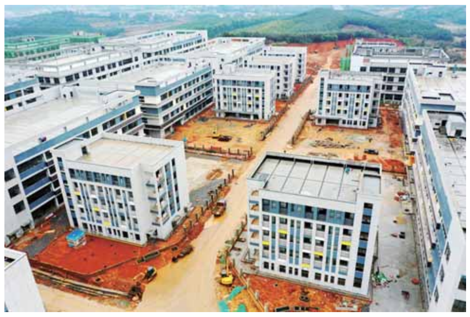
正在进行扫尾工程的服饰生产园。
